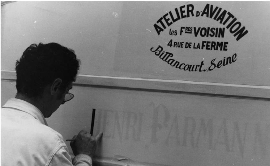
Figura 17 - In occasione dell'ultimo intervento sul Voisin 1 Bis, la tela è stata sostituita e sono state ripristinate le scritte dipinte. *Au cours de la dernière remise en état du Voisin 1 Bis, la toile a été remplacée et les marques peintes réappliquées.*
