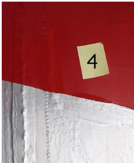
Figura 33 - Fase 4. L'applicazione di uno strato di colore rosso completa il restauro di questa lacerazione.
