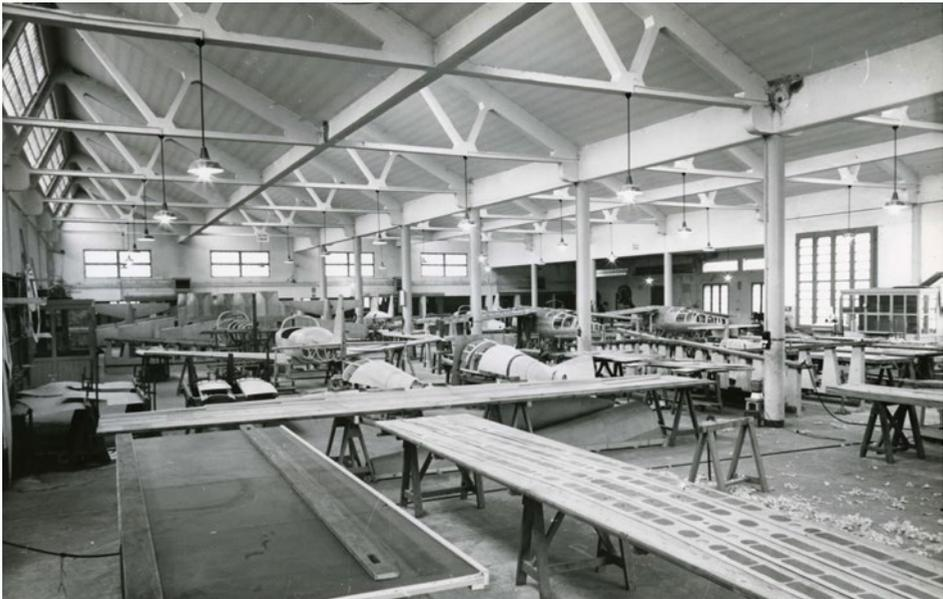
Figura 11 - Confronto tra le strutture reticolate di un aeroplano in costruzione all'interno del capannone dell'aeroporto di Gardolo e le carpenterie in calcestruzzo dei capannoni destinati alla produzione, fine anni Trenta/inizio anni Quaranta. [Soprintendenza per i beni culturali, Provincia autonoma di Trento, Archivio Fotografico Storico, Fondo miscelaneo (Ezio Groppa) e Fondo Fratelli Pedrotti].
